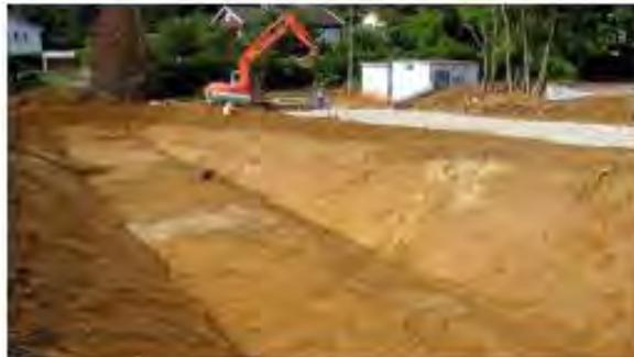
Figure 36 : Exemple de mise en place d'un bassin de rétention des eaux pluviales
